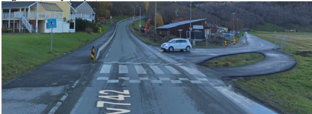
Gangfelt over Løvsetvegen, sett fra sør
